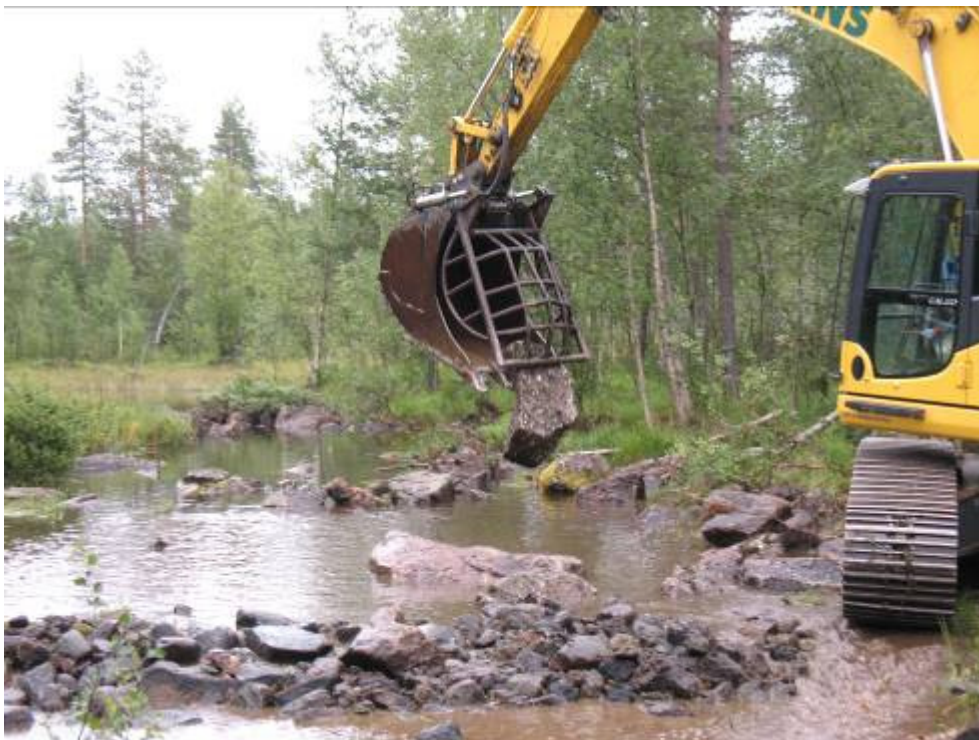
Bild 3 Grävmaskin på väg att lyfta ett block i Lidsträskbäcken.
