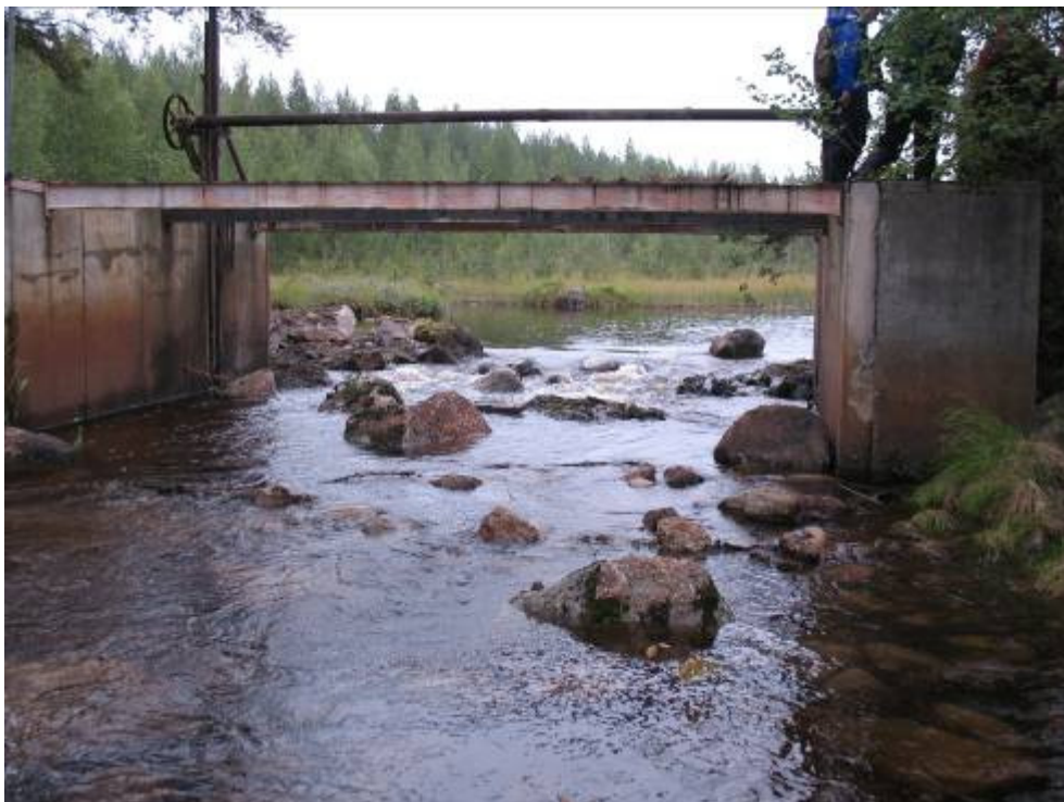
Bild 6. Slussgolvet vid Lidsträskdammen har ersatts av stenbotten.
