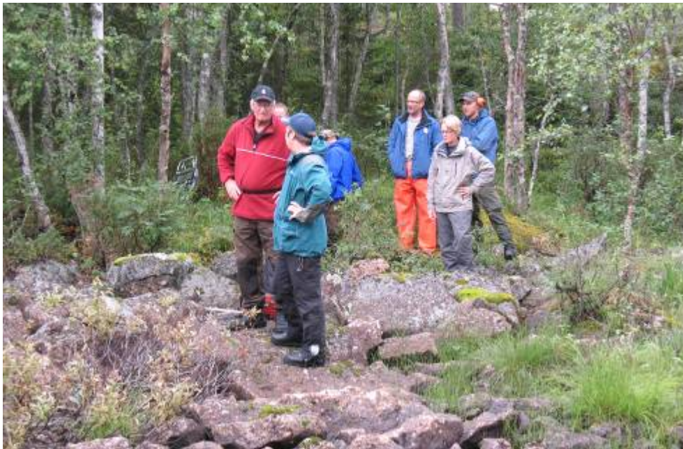
Bild 4. Vi studerar grävmaskinen i arbete i Lidsbäcken. Lägga märke till den ansamling av block och stenar som personerna står på. Det är material som tidigare till stor del legat i bäcken.
