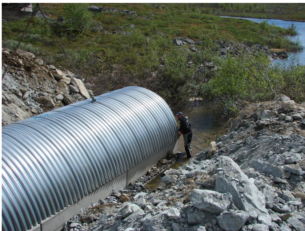
Figur 1: Byte av vägtrumma över Sitasvägen
