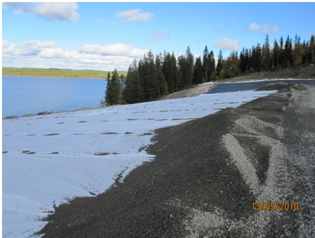
Skyddsduk ovanpå svetsad HDPE liner samt dränlager (grus)
