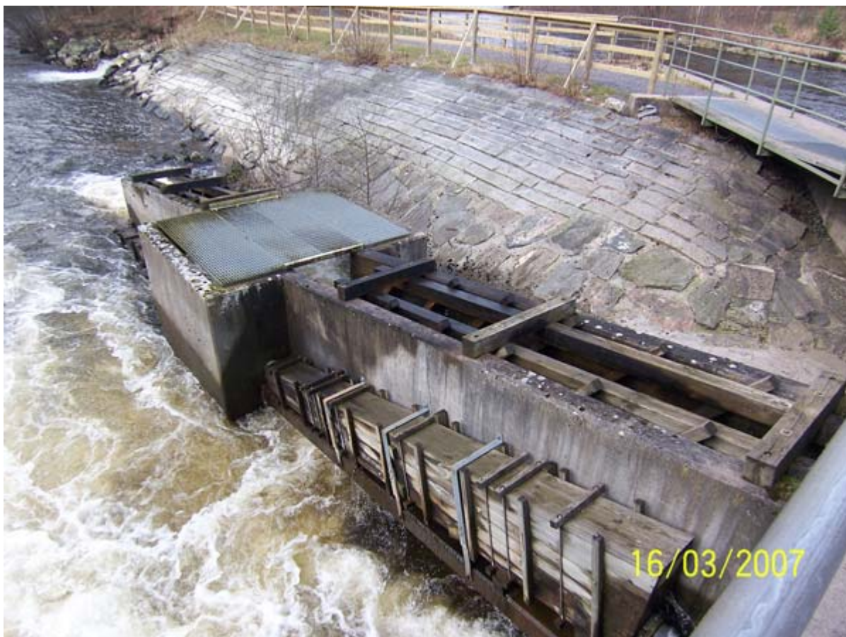
Figur 1 Fiskväg för lax och öring samt ålyngelledare vid Jonsereds kraftstation i Säveån.
