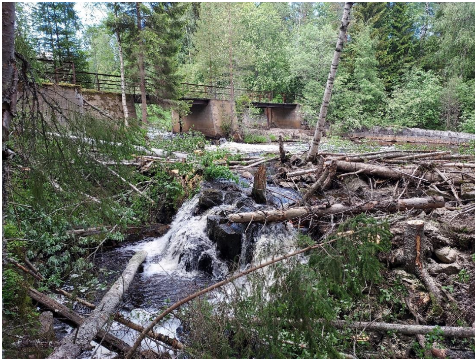
Bild före åtgärd, totalt ca 2,5m fallhöjd. Vattenintag in mot tub till kraftverksturbin längst ner till vänster i bild. (endast stålringar till tub kvar på platsen.)
