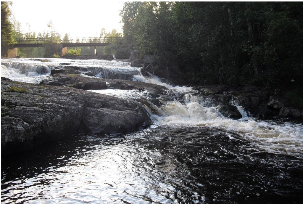
Vattenfall med den före detta kraftverksdammen längts upp på fallet. Efter restaurering nu något lägre fallhöjd ner mot agga. (bild före åtgärd)
