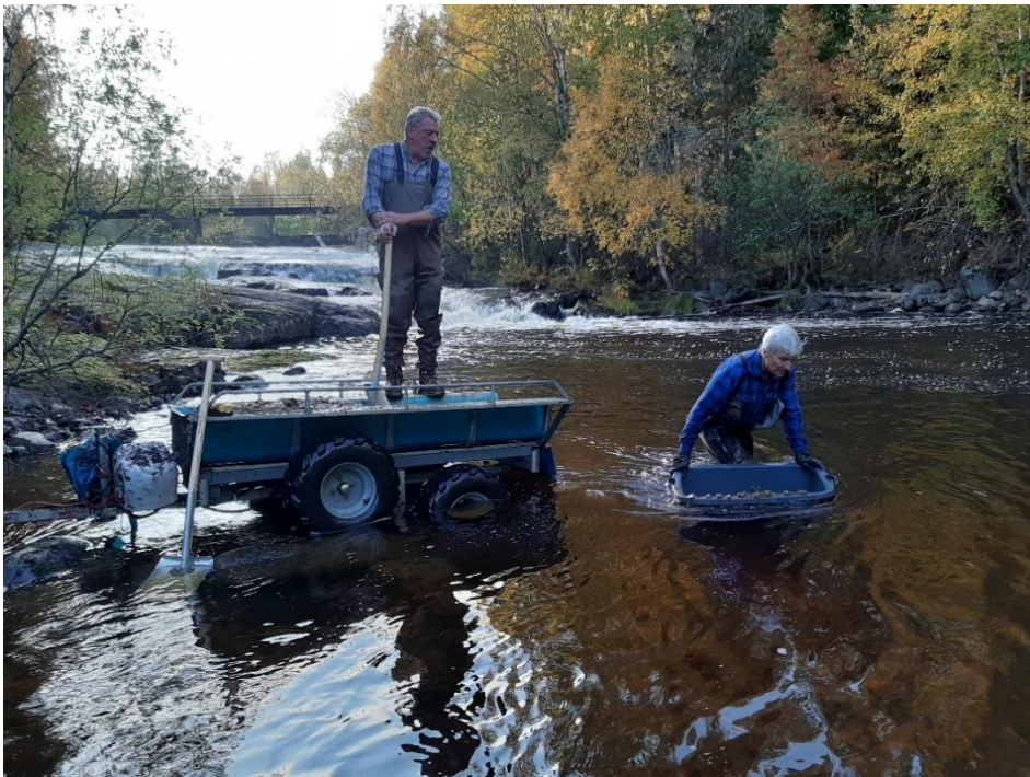
Pågående grusutläggning, Stefan och Ove hjälps åt att lägga ut gruset.
