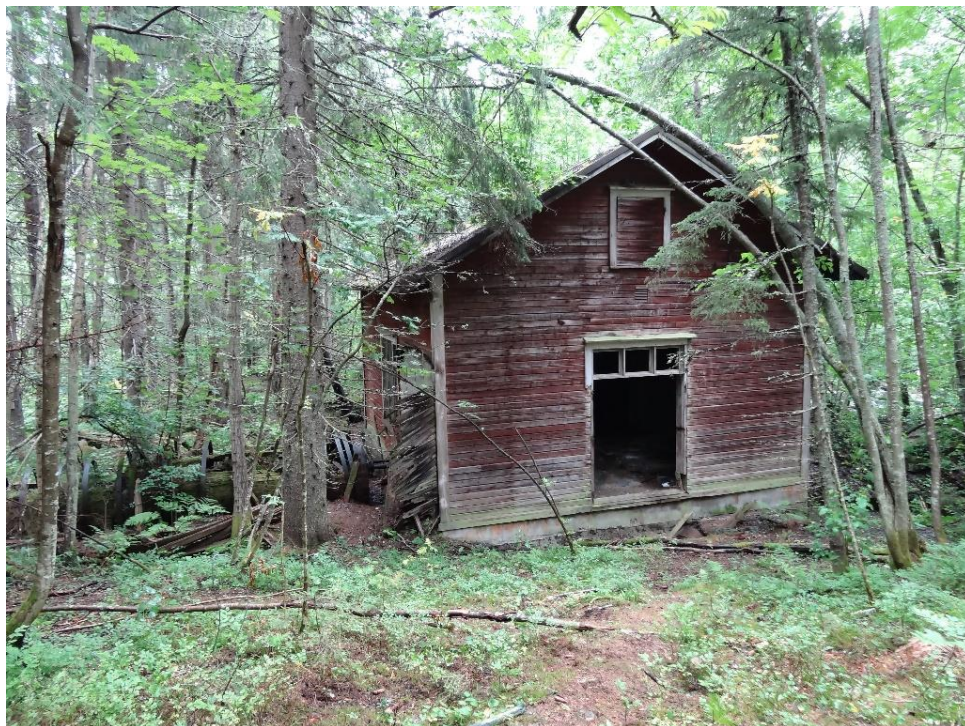
Kraftverksbyggnad i Leduforsen. Rester av tub med stålringar till vänster om byggnad.
