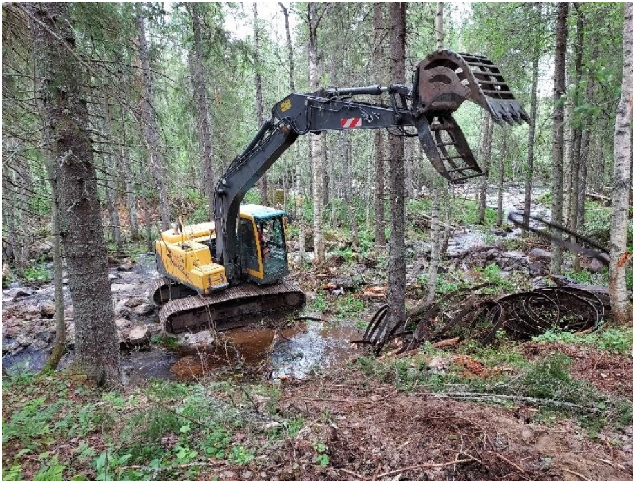
Kristoffer plockar metallskrot med grävaren.
