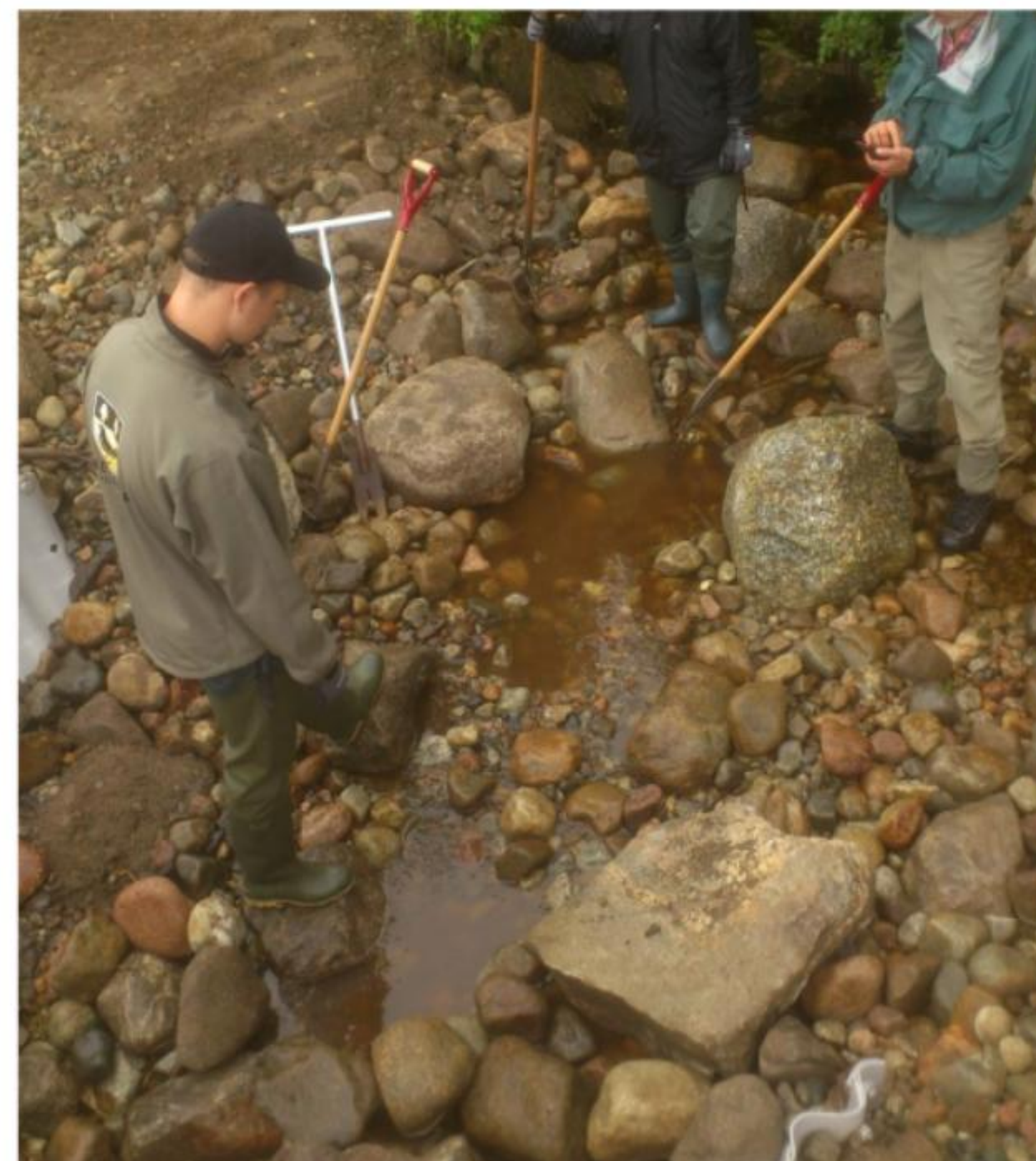
Två lekbottnar byggdes vid den nya trumman i Aftonmorbäcken. Därtill flyttades stenar inne i den nya trumman, så att en fullt fungerande fåra bildades.
